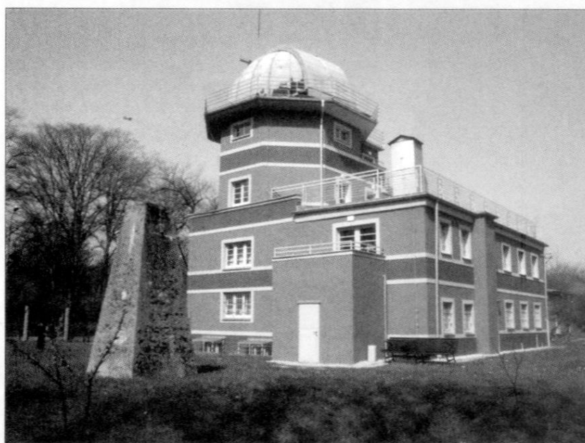
Fot. 1. Budynek Instytutu Astronomicznego we Wrocławiu — po lewej stronie widoczny jest słup, na którym stało nieruchome lustro sferyczne. Lustro to oraz uranostat zostały zdemontowane
